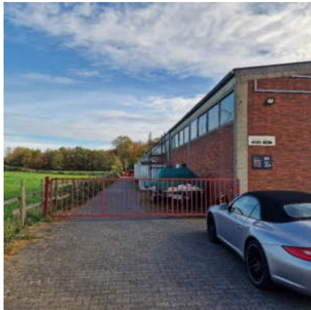
Zufahrt zum hinteren Bereich des Grundstücks
