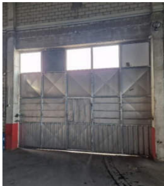
Schiebetor mit Tür vorne
