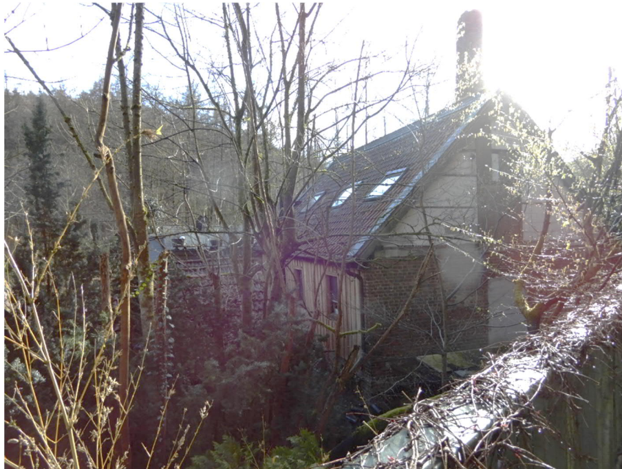
Gebäude D von der Morsbachtalstraße aus
