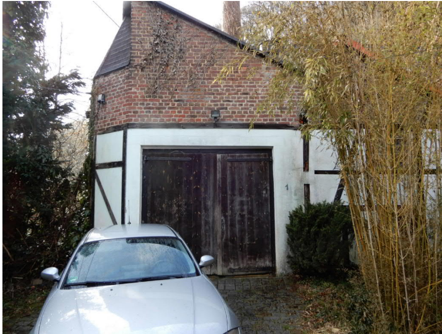
Gebäude C, Zugang
