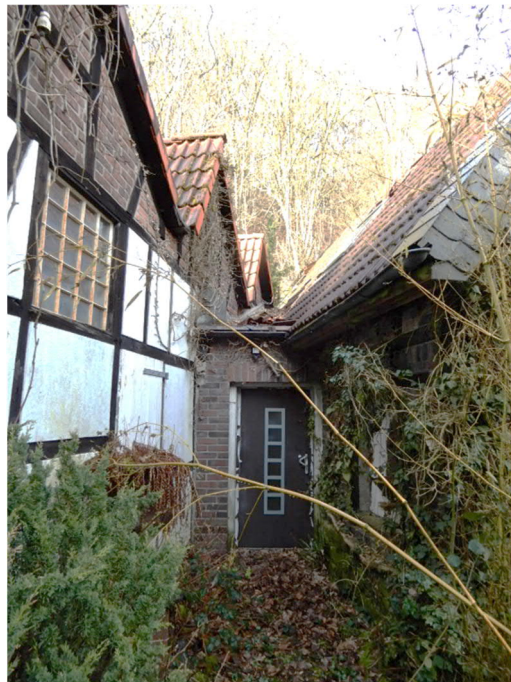
Gebäude C und B (links) Zugang zu Gebäude A und B (mitte) Gebäude A (rechts)
