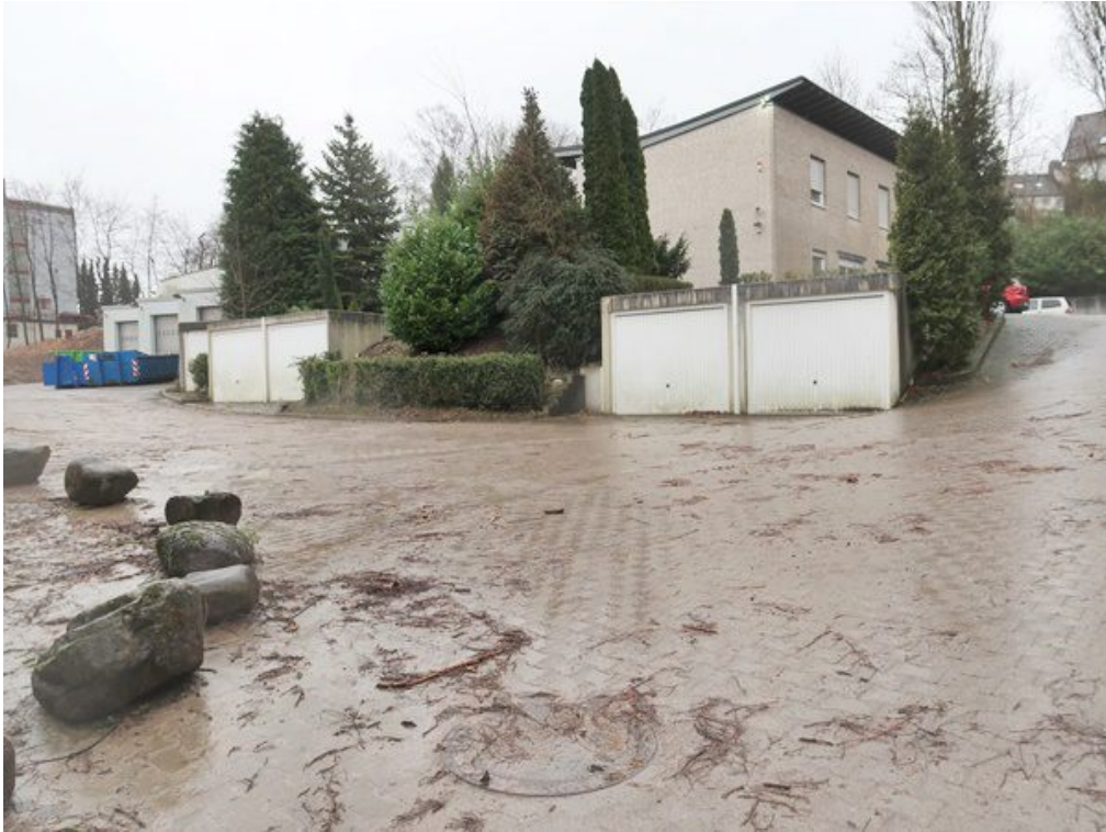
Ansicht von der Zufahrt
