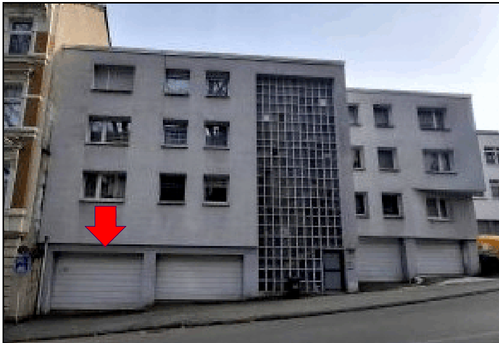
Foto 1: Gebäudeansicht, links Garage Nr 15
