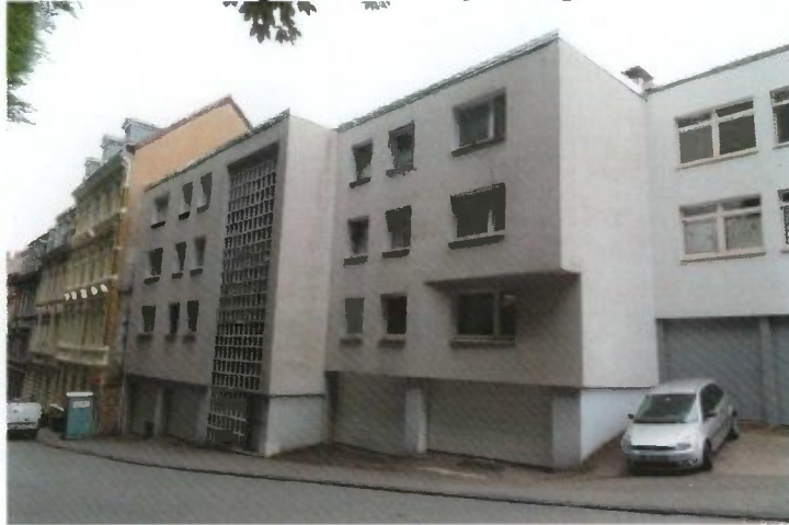
Straßenseitige Ansicht Nützenberger Str. 79
