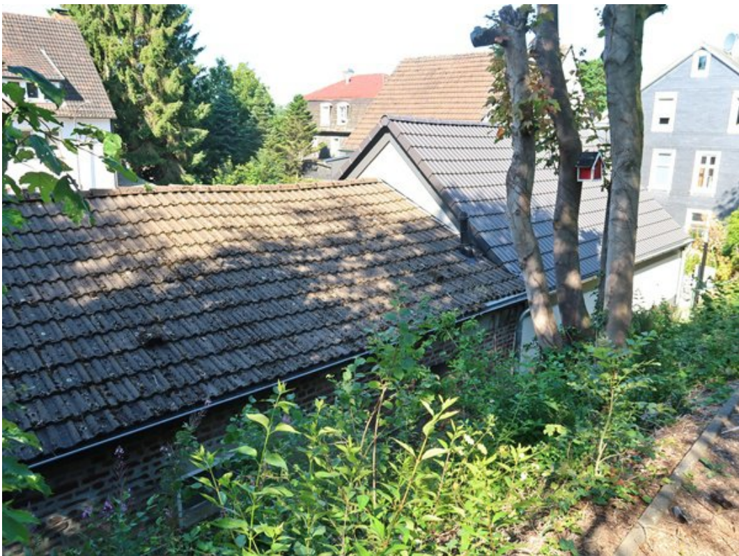
Ansicht Gebäuderückseite: Links das Lagergebäude, rechts das Einfamilienhaus
