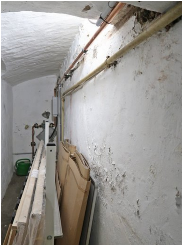
Feuchteschäden Wandfläche
