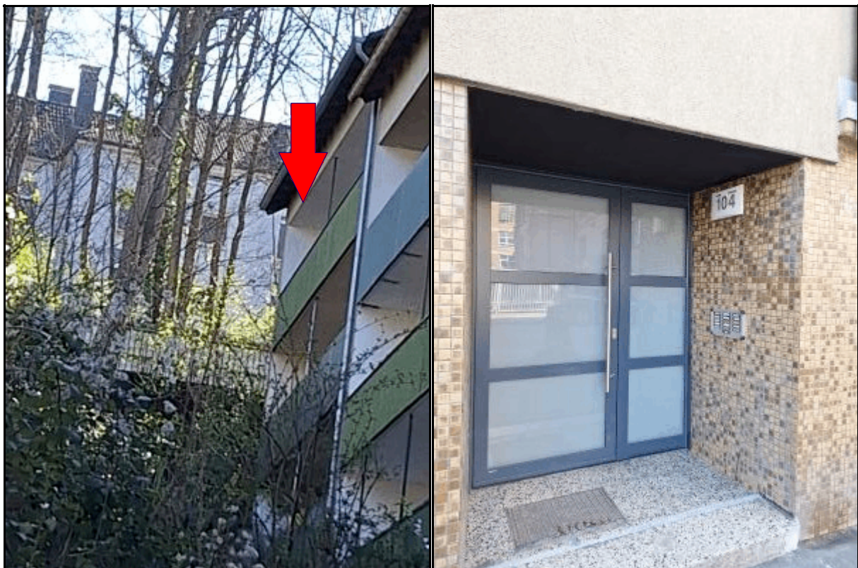
Foto 2: Blick auf den Balkon der Wohnung
