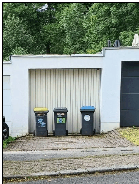
Garage als Reihengarage mit Flachdach.
