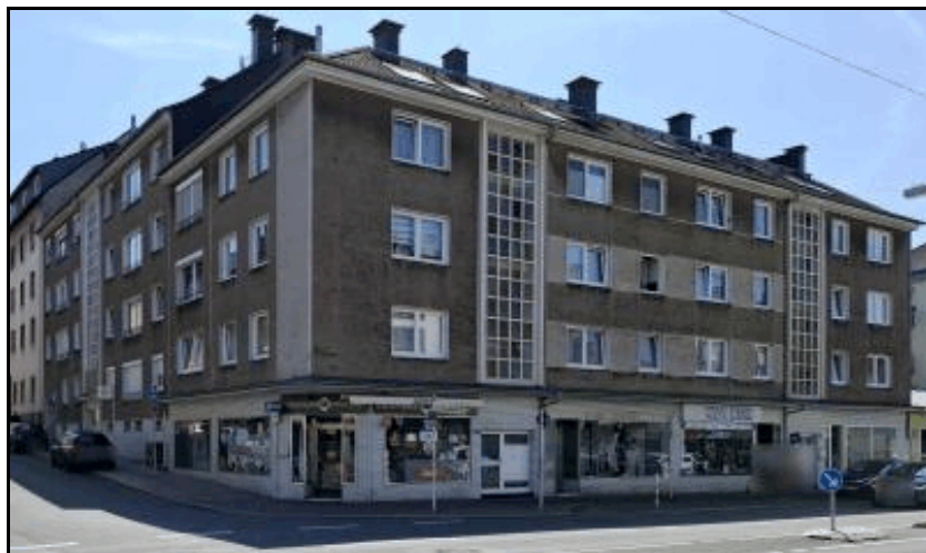
Foto 1: Blick auf die Eigentumsanlage
