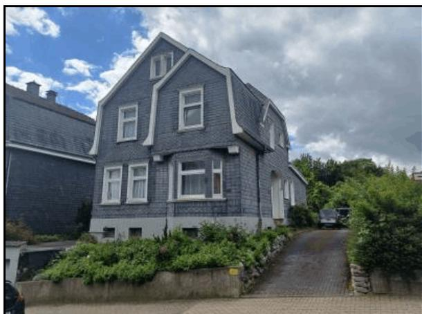
Ein unterkellertes, zweigeschossiges Einfamilienhaus mit Mansard-Satteldach, Anbau mit Flachdach und Garage mit Flachdach. Das Wohnhaus wurde um 1911 erbaut. Der Bau der Garage erfolgte später, vermutlich in den 1950er Jahren. Die Fassade und ein Teil des Daches sind in Schiefer ausgeführt.
