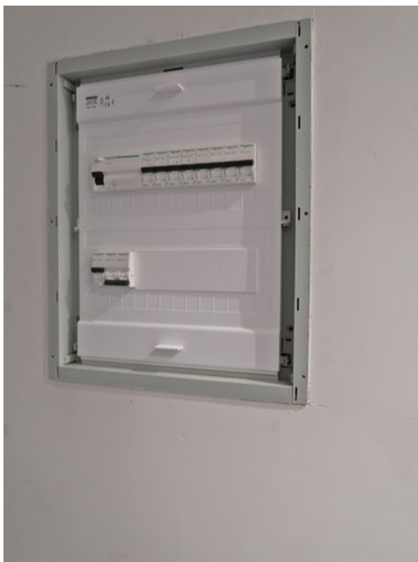
Elektrounterverteilung
