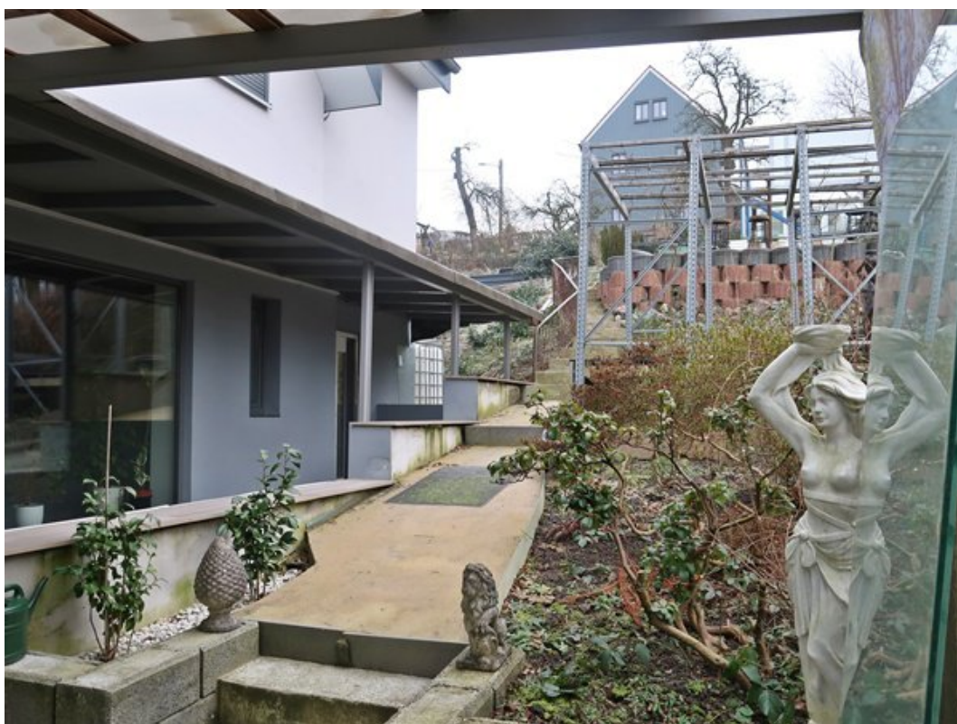
Überdachter Hauseingangsbereich und Zuwegung zur rückseitigen Gartenfläche
