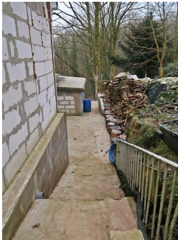
Wegefläche entlang der nördlichen Giebelseite, hinten links der 1-geschossige Anbau mit Heizölvorratstank
