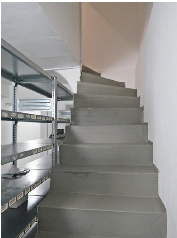
Treppe zum Untergeschoss von der Wohnung im Erdgeschoss
