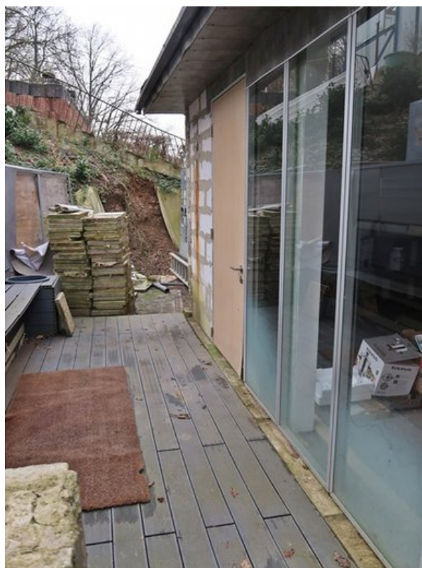
Terrassenfläche mit Zugang vom Wintergarten Erdgeschoss
