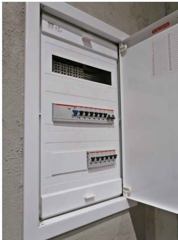
Elektrounterverteilung
