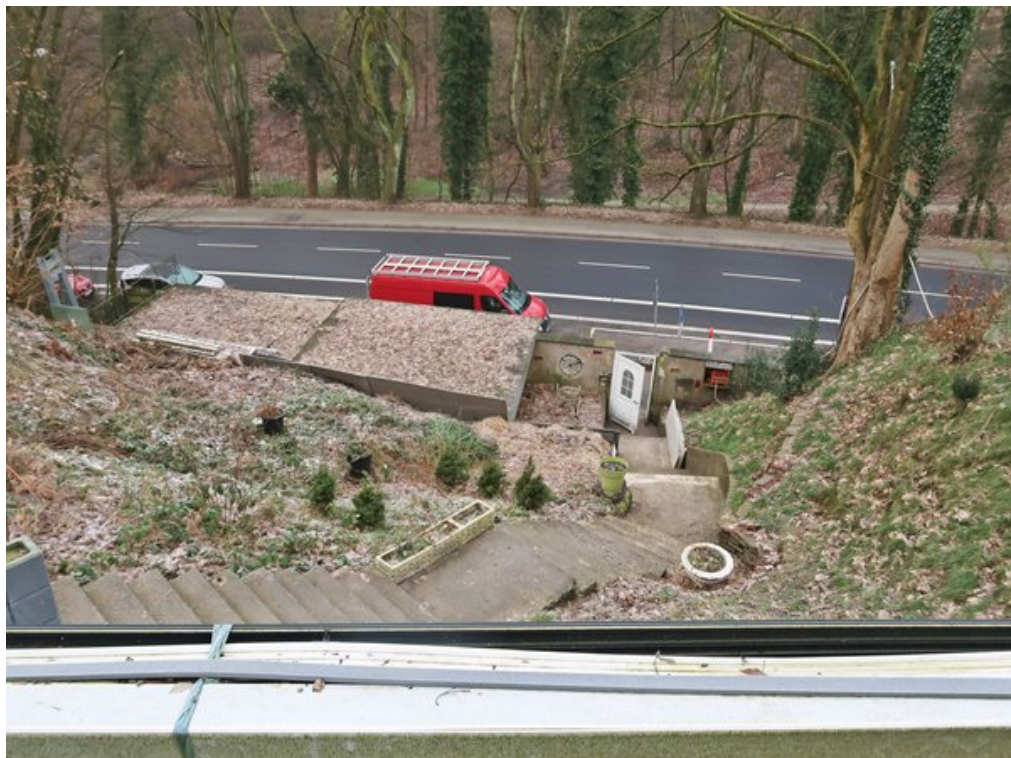
Vordergrundstücksfläche mit Treppenanlage als Zuwegung von der Nevigeser Straße
