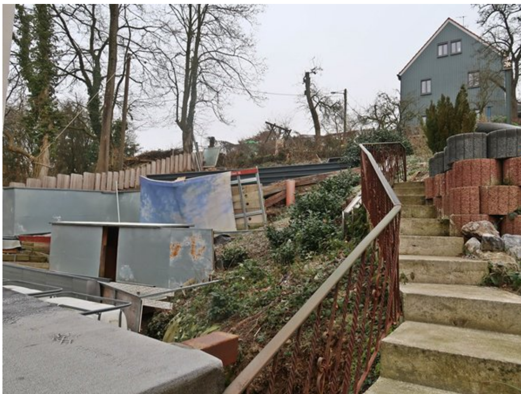
Rückseitig gelegene Gartenfläche mit provisorischen Hangabfangungen
