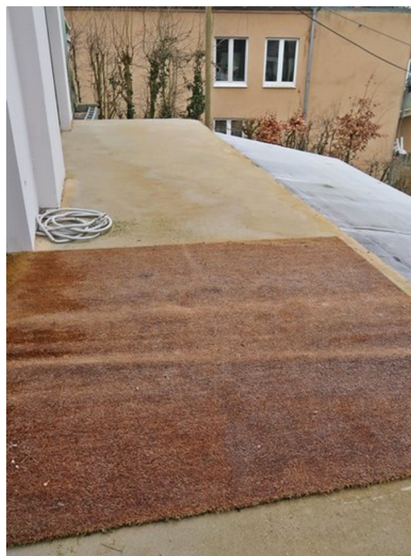
Terrassenfläche mit Zugang vom Wohn-/Esszimmer Erdgeschoss
