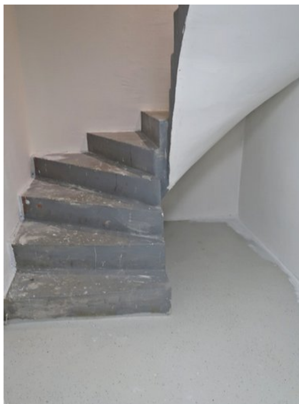
Treppe zum Kellergeschoss
