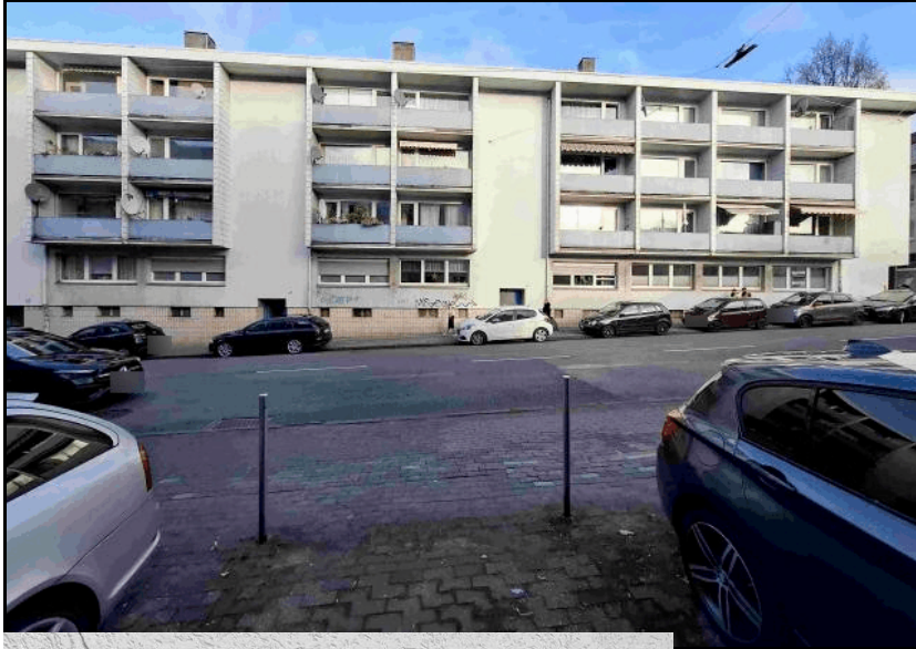
Foto 2: Blick auf das Gebäude Nr. 49
