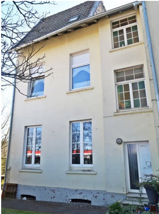
Teilansicht rückseitige Fassadenfläche
