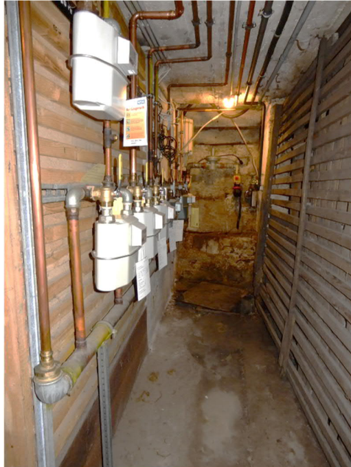
durchfeuchteter Hausanschlussraum
