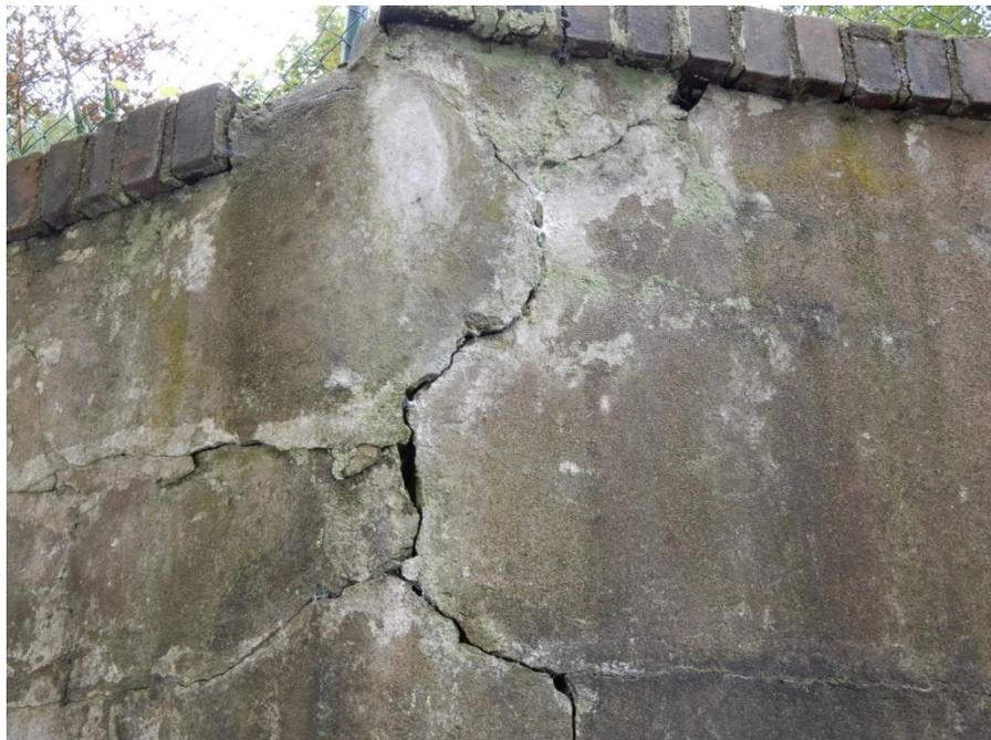
Schaden am Mauerwerk der Stützmauer zum Garten, beispielhaft
