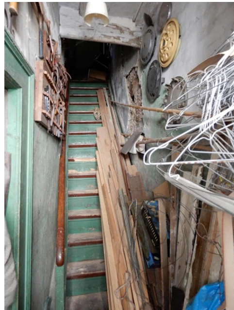
Treppe zum OG des Hinterhauses
