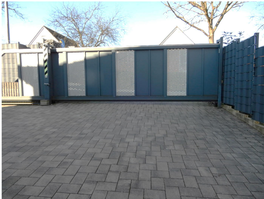
Stahlschiebetor an Grundstückseinfahrt
