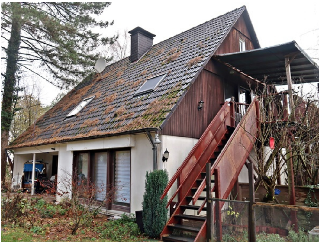
Ansicht Giebelseite mit Balkonanbau und Treppe zum Garten
