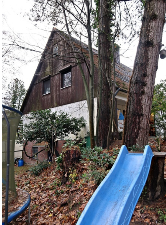
Ansicht von der Giebelseite
