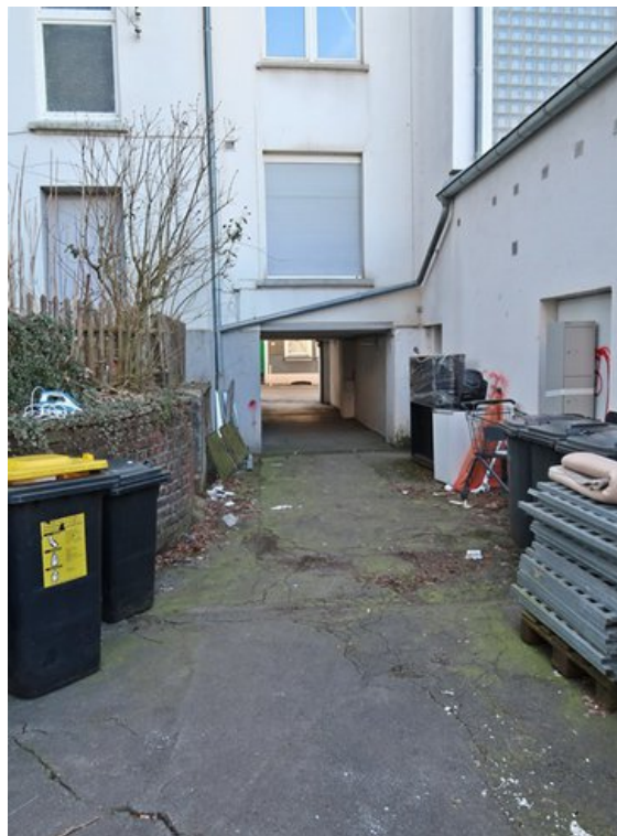
Durchfahrt zur Wiescher Straße und Teilansicht Hofffläche
