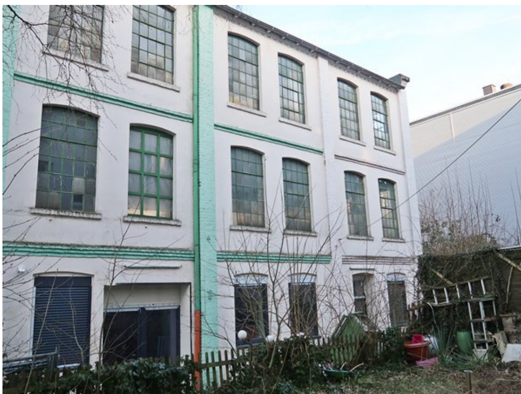
Teilansicht Fassade Wiescher Straße 1b
