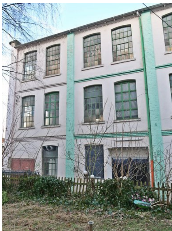
Teilansicht Fassade Wiescher Straße 1b
