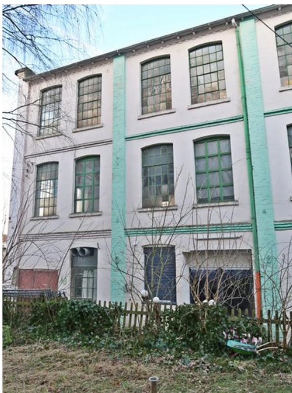
Teilansicht Fassade Wiescher Straße 1b
