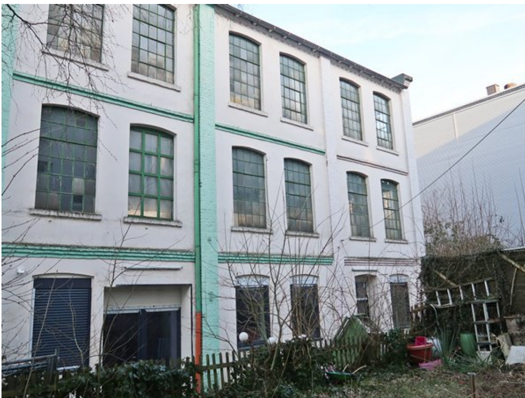
Teilansicht Fassade Wiescher Straße 1b
