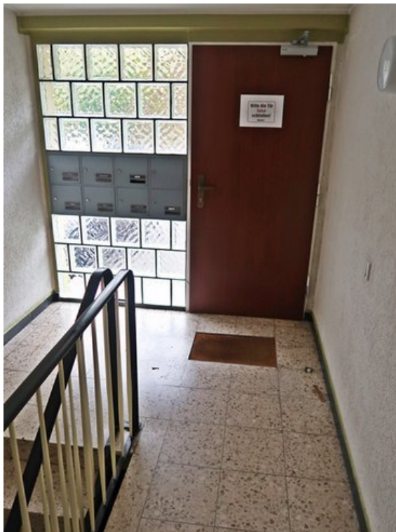
Treppenhaus mit Hauseingangstür
