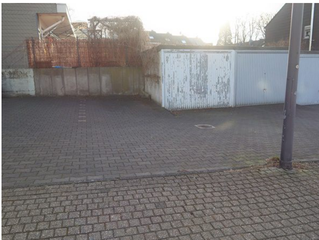
Zum Bewertungsumfang zugehörige Garage, links außen und links daneben der zugehörige Stellplatz
