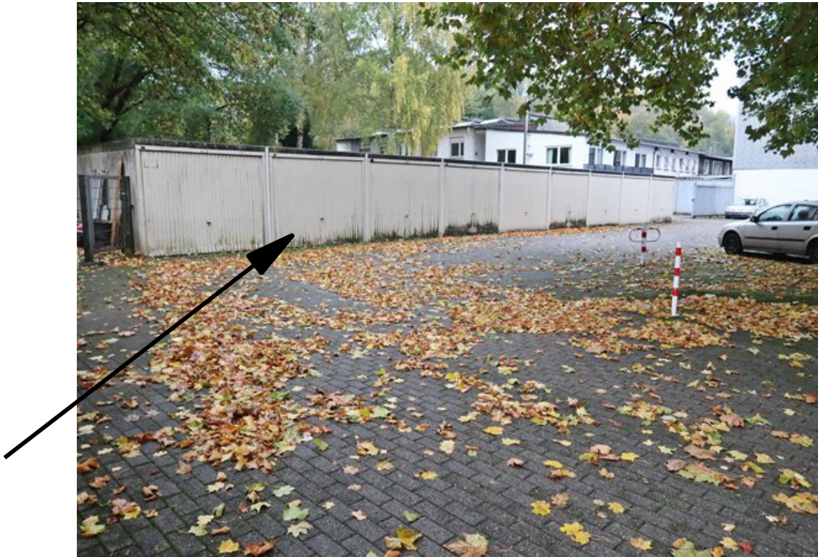
Garagenhof mit Reihengaragenanlage
