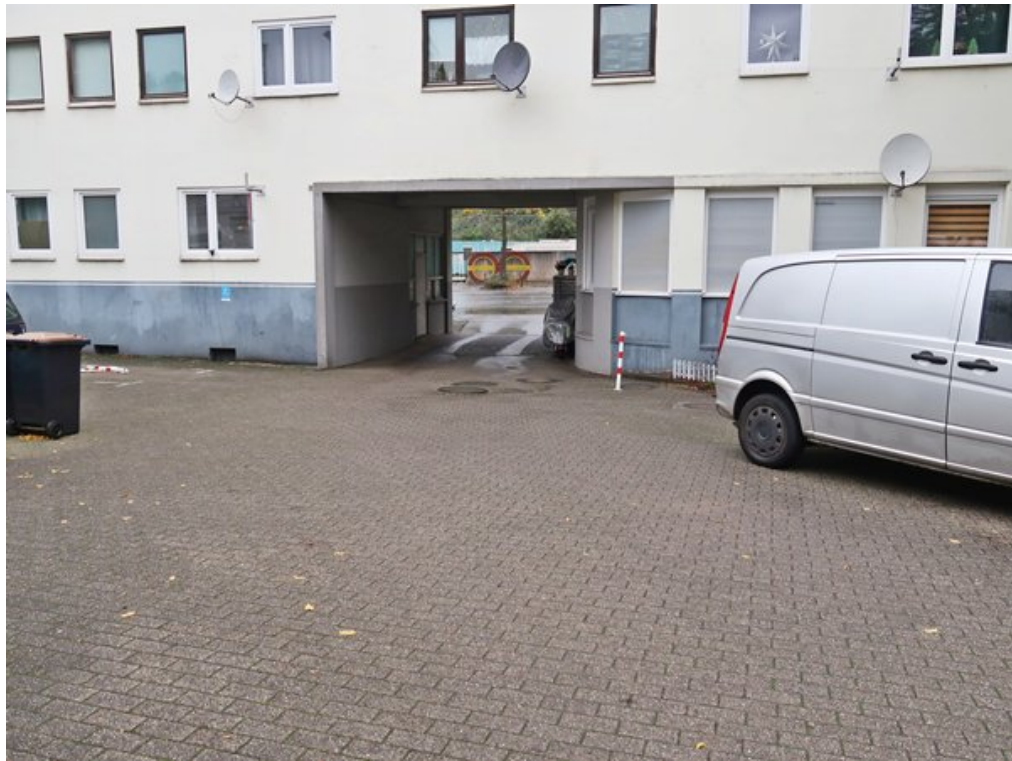
Zufahrt von der Straße Höfen
