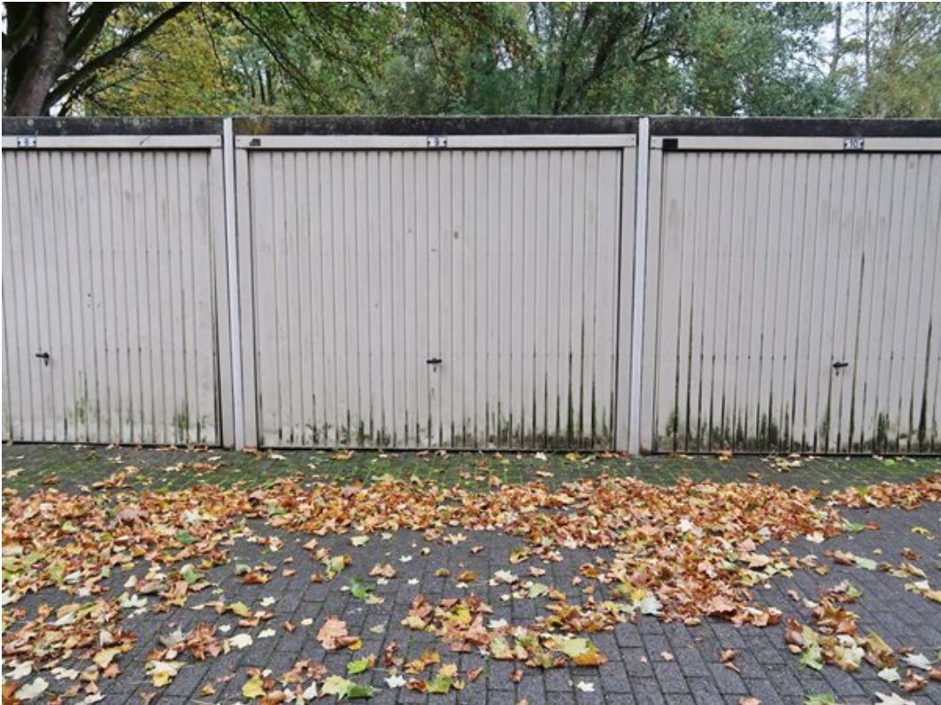
Ansicht Garage Nr. 73
