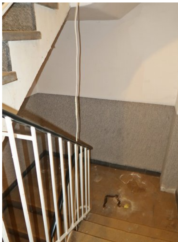
Treppe zum Kellergeschoss
