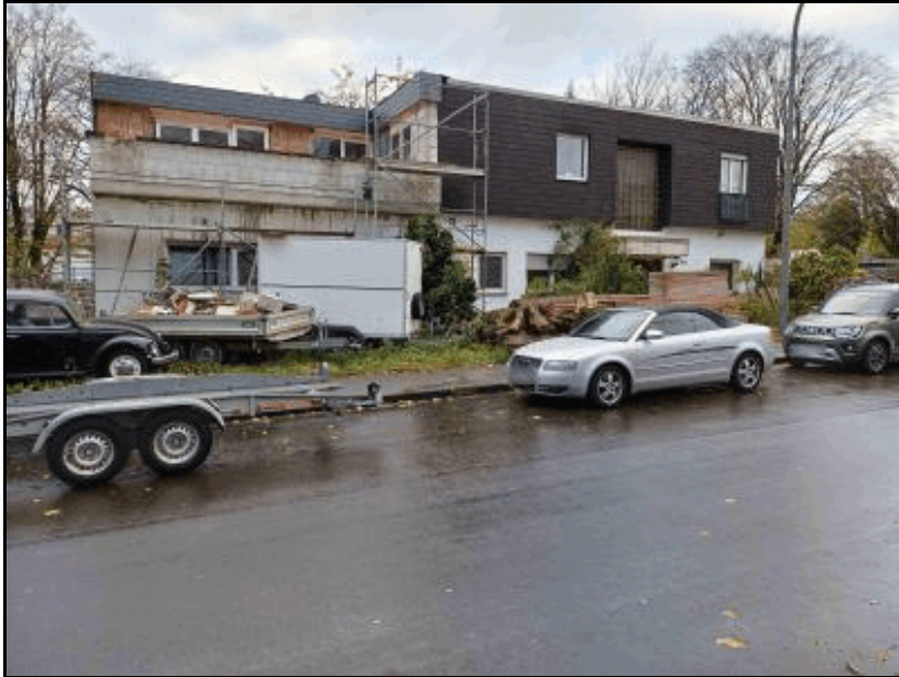
Foto 1: Gebäudeansicht von der Straße
