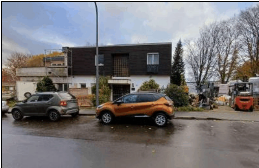
Foto 2: Gebäudeansicht von der Straße
