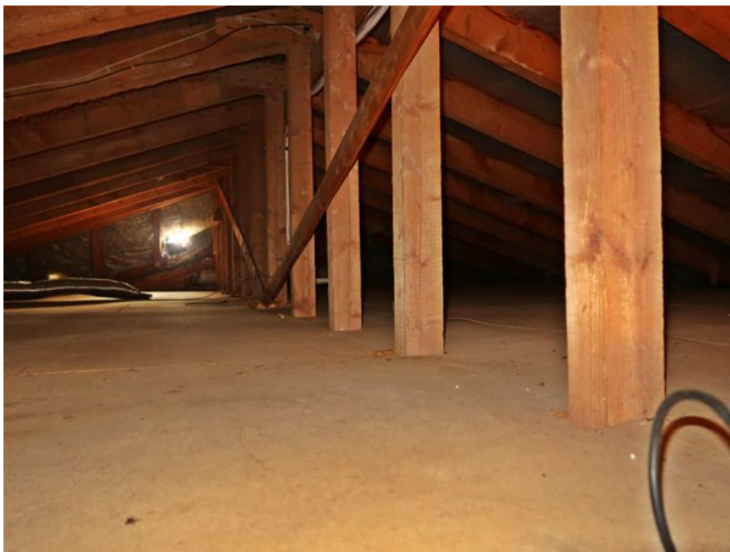
Dachraum über dem Dachgeschoss
