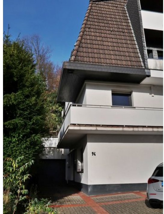
Seitenansicht, links die Einzelgarage, rechts daneben die Zugangstür zur Wohnung 1
