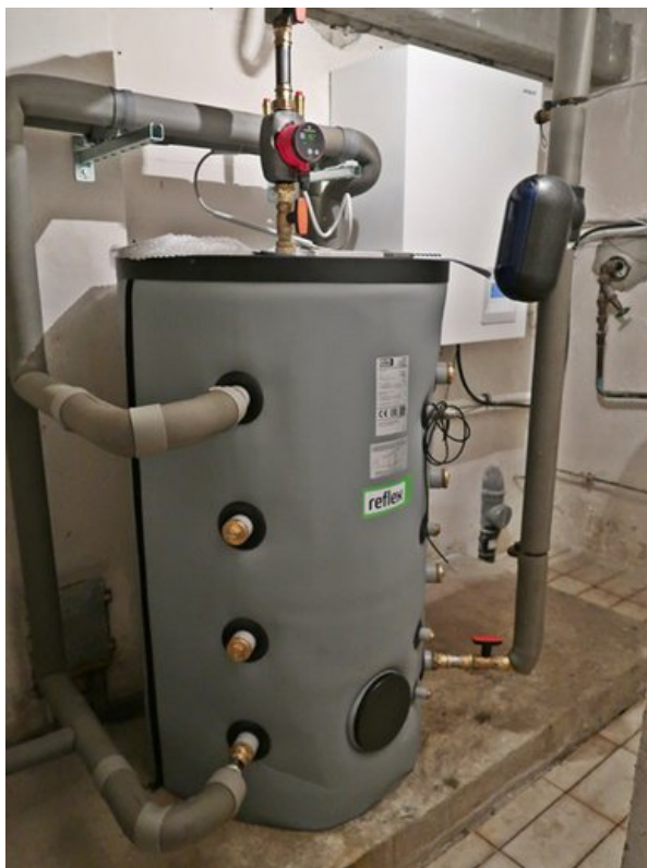
Warmwasserspeicher
