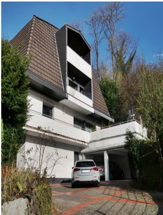
Zufahrt zur Doppelgarage, rechts daneben die Zugangstreppe zur Wohnung 2
