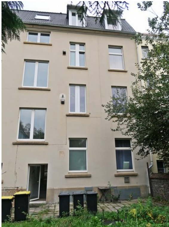
Teilansicht rückseitige Fassadenfläche
