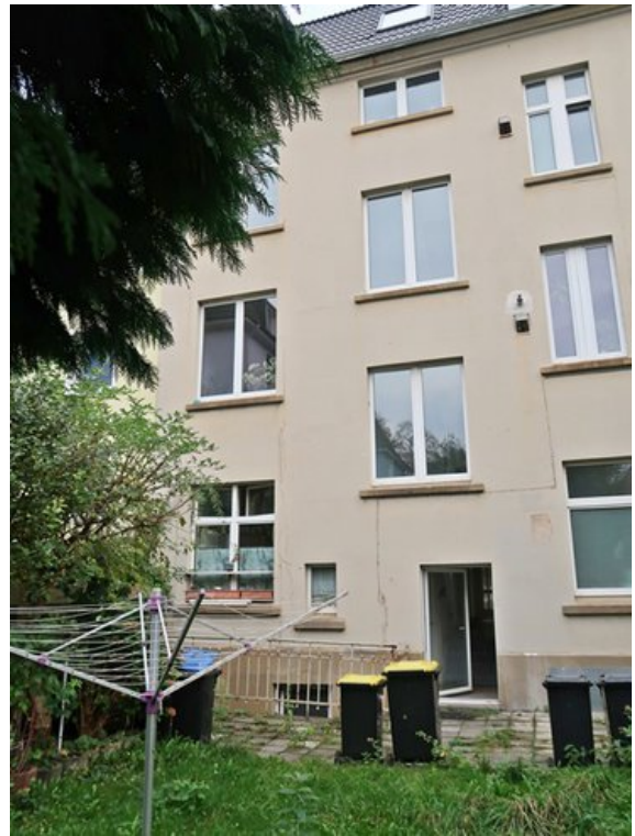
Teilansicht rückseitige Fassadenfläche
