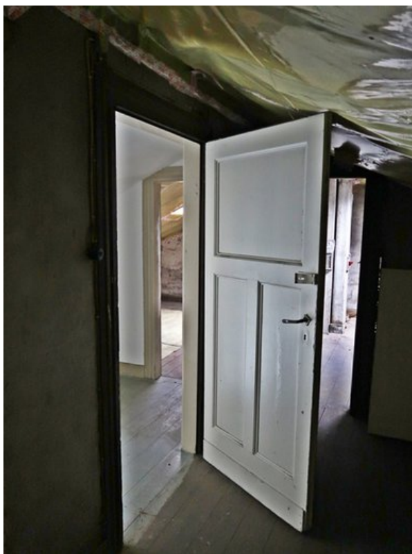
Zugangstür vom Treppenhaus, im Bildhintergrund die Zugangstür zu Raum 2
