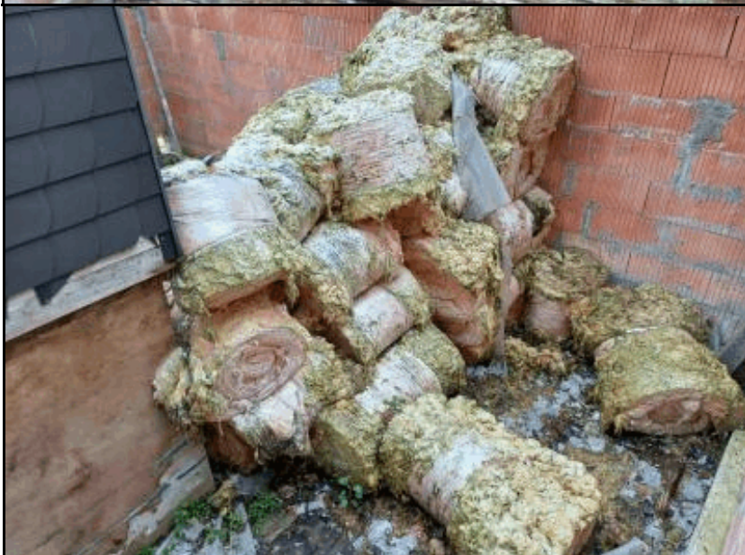
Foto 6: Dämmmaterial verrottet
