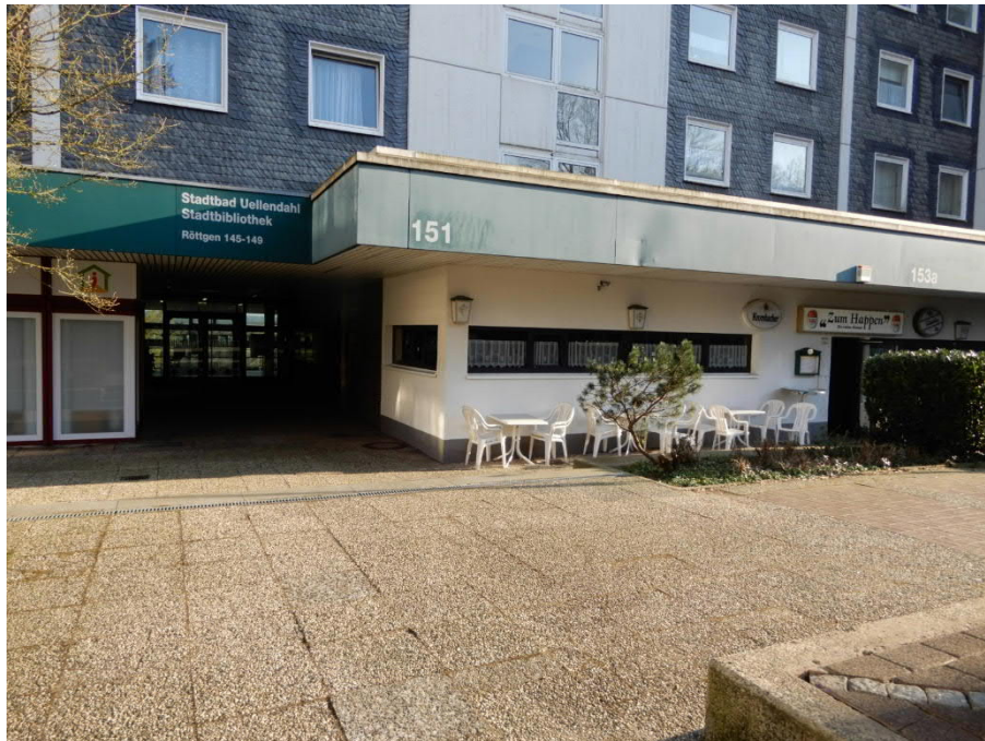
Zugang zu Haus Nr. 151
