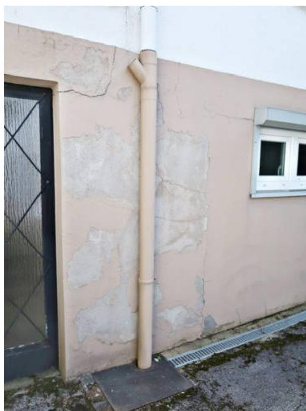
Teilansicht Fassadenfläche mit Risschäden und Abplatzungen
