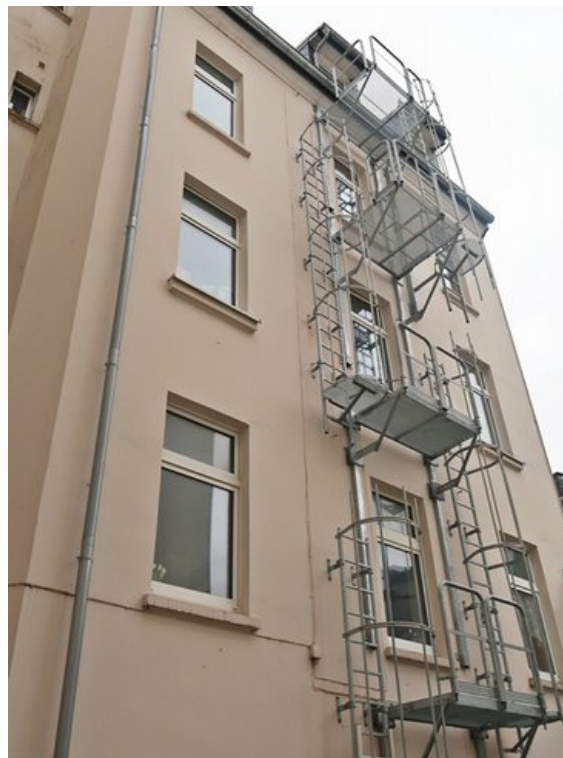
Teilansicht Fassade hofseitiger Anbau
