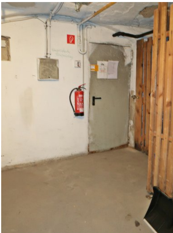
Flur mit Zugangstür zum Heizungsraum, zum Ortstermin nicht zugänglich
