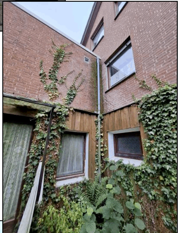
Foto 2: Rückseite Garage und Giebel Wohnhaus
