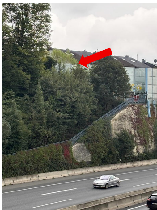
Rückansicht von der Fußgängerbrücke über die A 46
