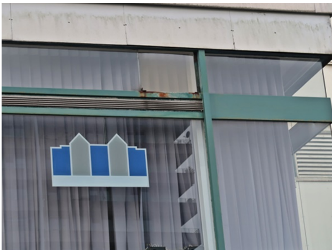
Teilansicht Fenster Obergeschoss mit Korrosionsschaden am Rahmen
