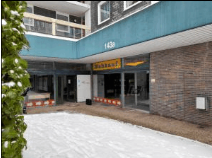
Foto 2: Eingänge zum Objekt
