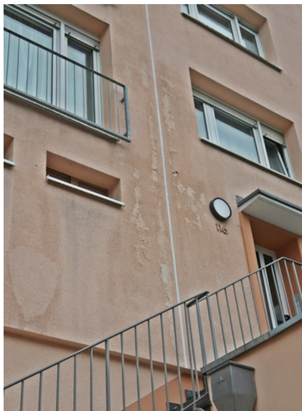
Straßenseitige Fassadenansicht mit Verfärbungen und Abplatzungen
