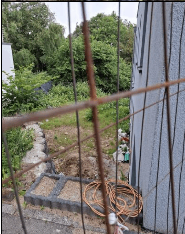
Foto 3: Treppe, Podest und Terrasse zur ETW 1 fehlen
