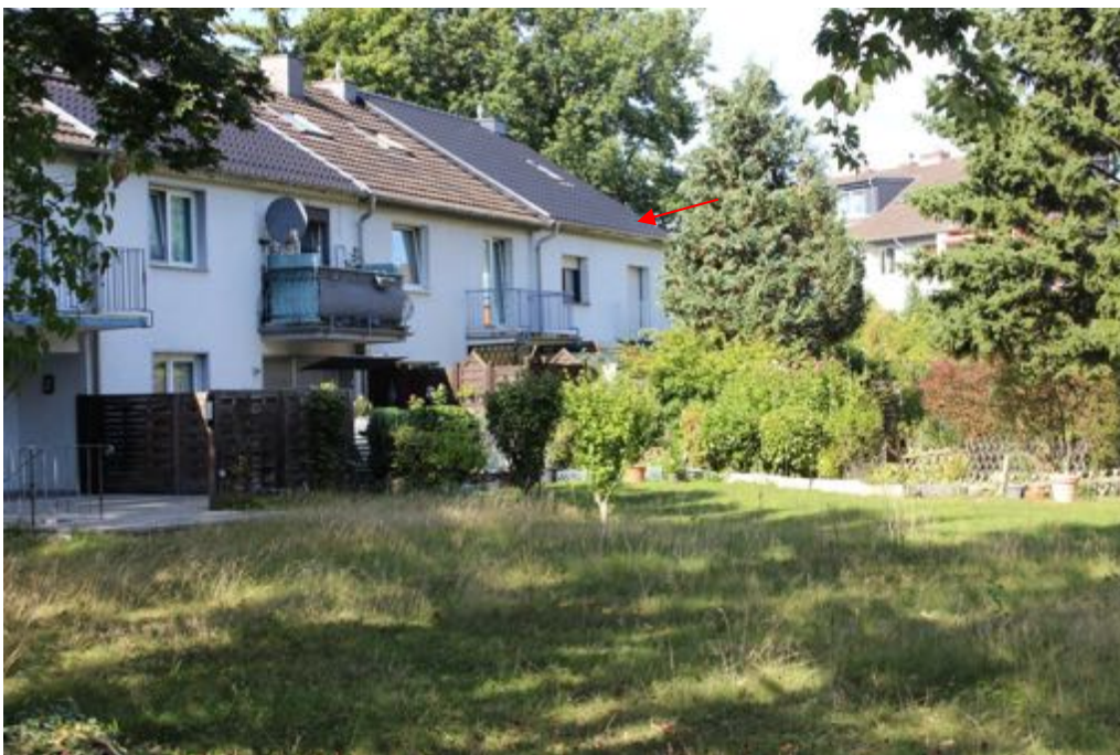
Bild 2: Gartenansicht Verdistr. 21 bis 27
