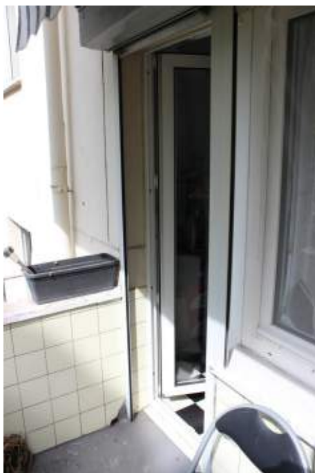
Bild 28: Wohnung 2.OG: Balkon
