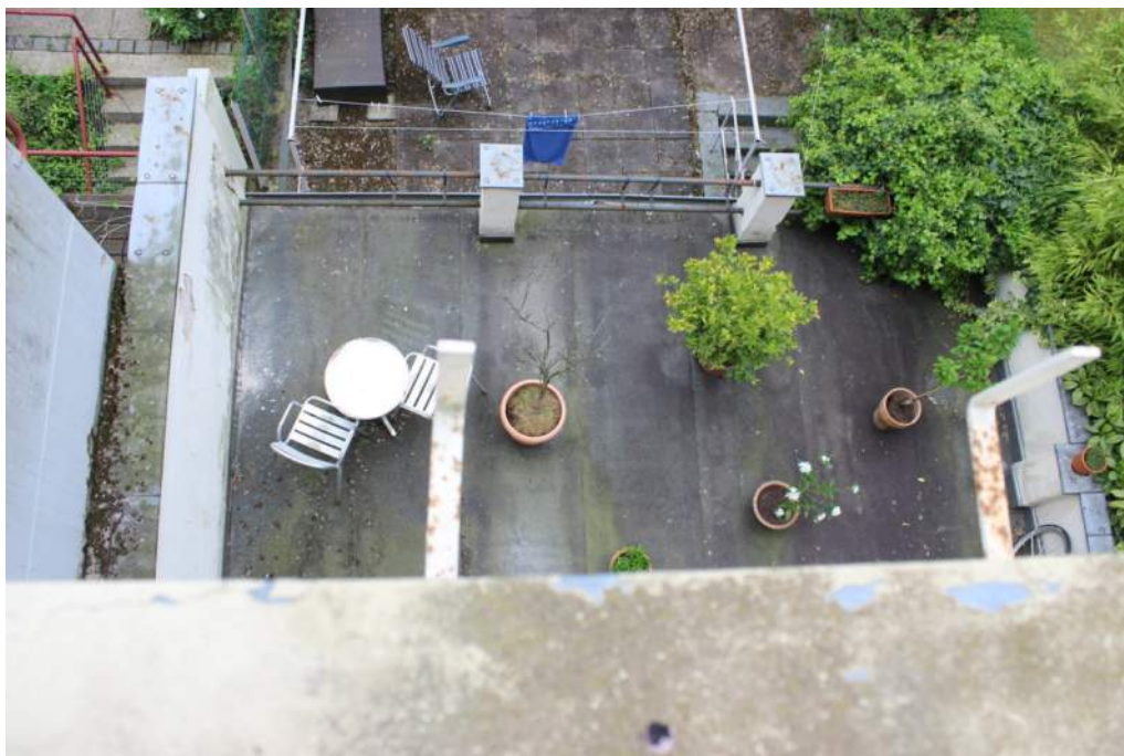
Bild 22: Blickrichtung Dachterrasse 1.OG
