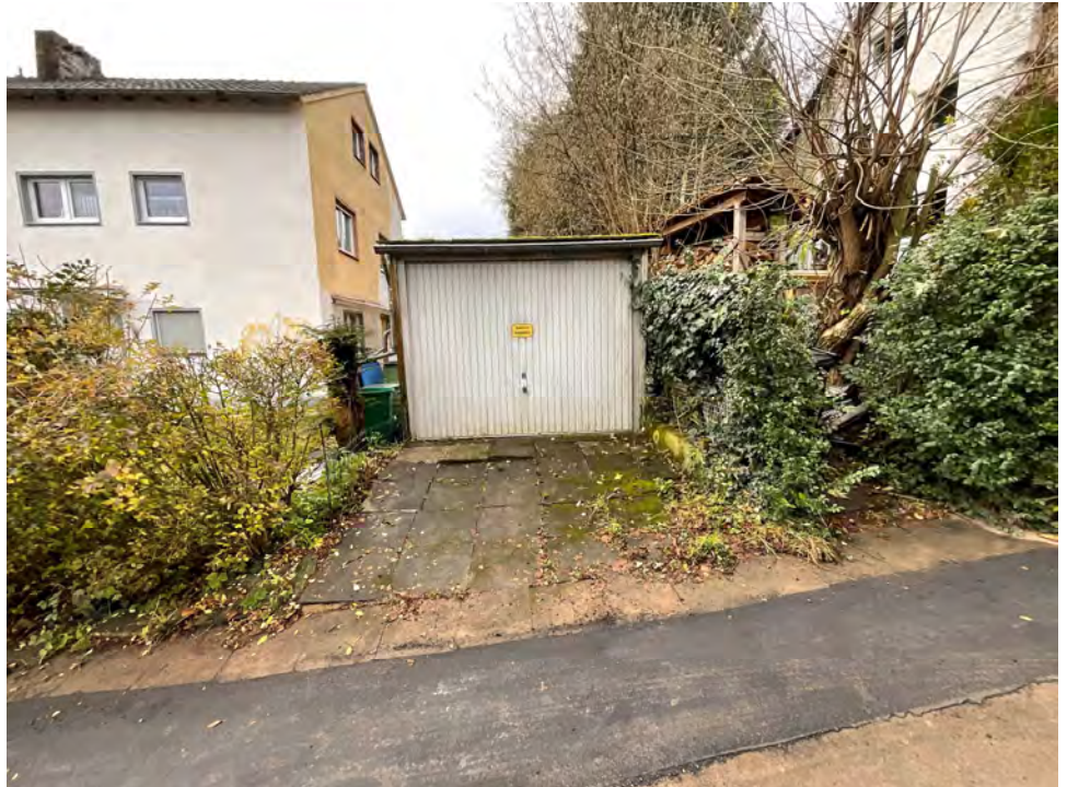
Lichtbild 5: Detail, Stahlbetonfertigteiltergarage, Vorplatz überbaut auf Flurstück 2021
