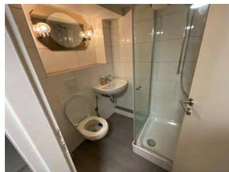
Lichtbild 11: sanitäre Einrichtungen Duschbad/WC im Kellergeschoss
