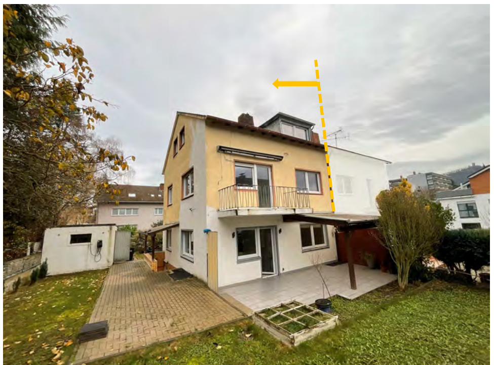
Lichtbild 6: Detail, Außenbereichsorientierung mit Blick auf die Terrasse, den Balkon, die Dachgaube und die rückseitige Garage
