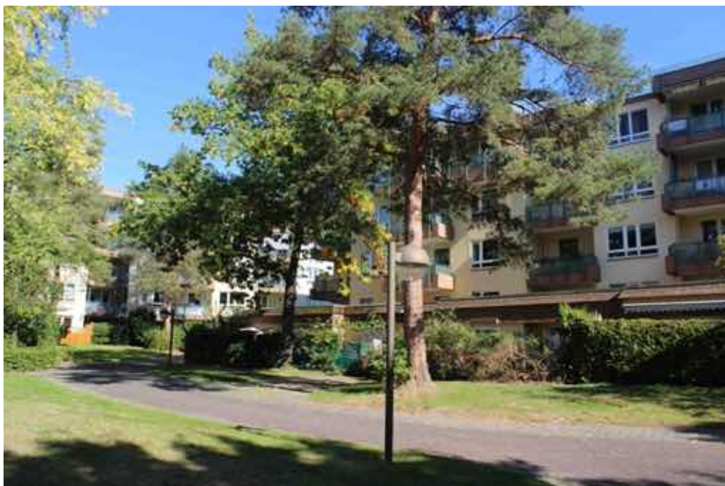
Bild 4: Garten-Ansicht bzw. West-Ansicht, Celsiusstr.122
