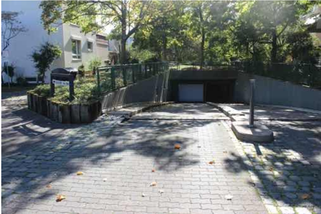
Bild 1: Tiefgarage: Zufahrt Celsiusstraße
