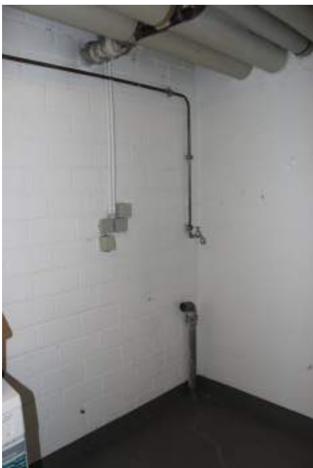
Bild 30: Kellergeschoss: Waschküche Bild 31:
