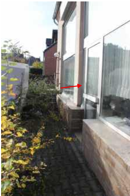
Bild 4: Vorplatz „Olsdorf“, Eingang Tiefparterre
