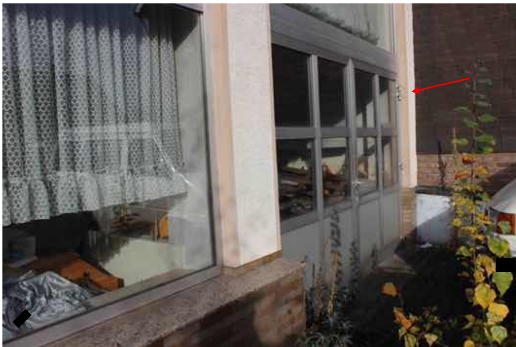
Bild 6: Vorplatz „Olsdorf“, Garagentor
