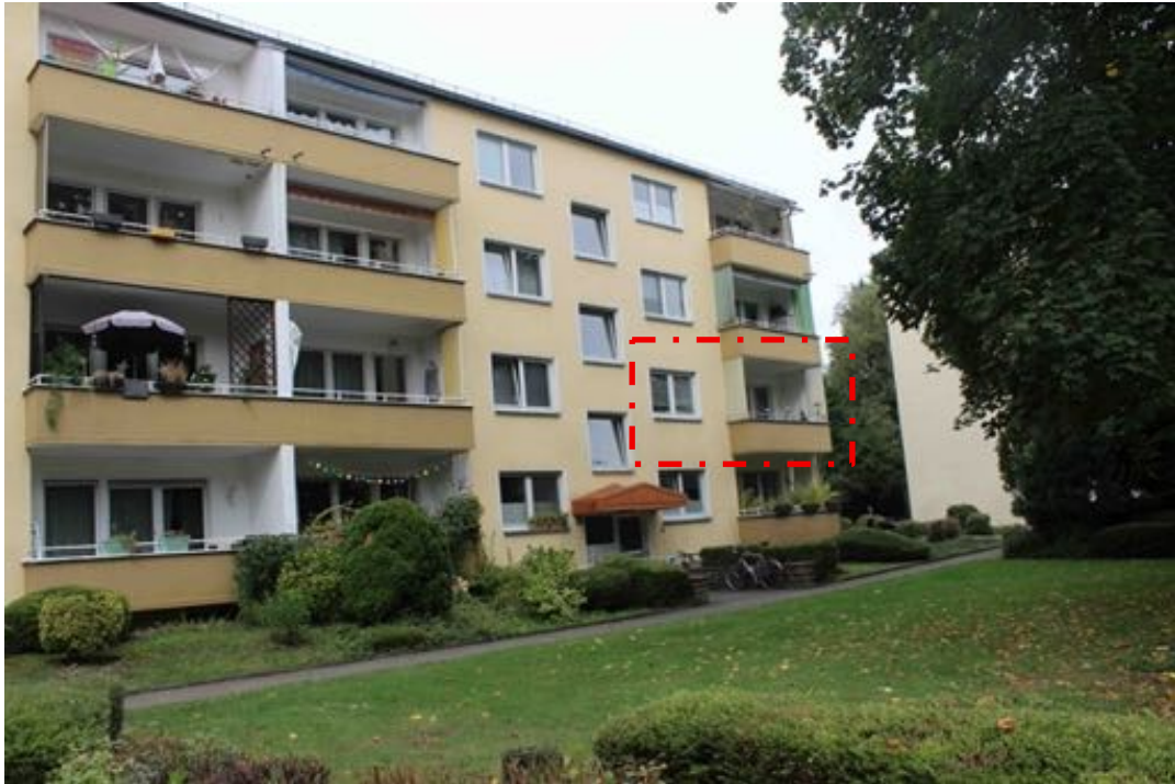
Bild 1: Ansicht Gottfried-Kinkel-Straße (Süd-Ost-Ansicht)
