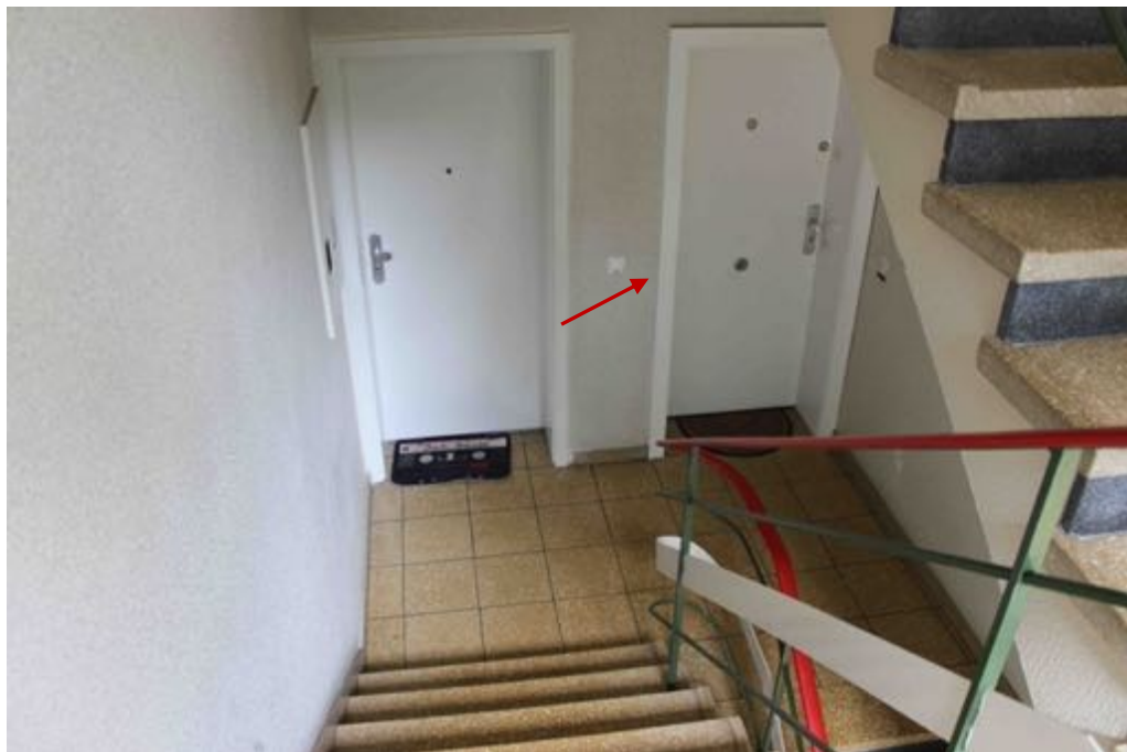
Bild 7: Treppenhaus 1.OG, rechts: Sondereigentum Nr. 44
