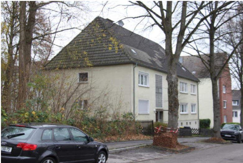
Bild 1 Straßenansicht Hauseingang und Zufahrtstor zum Hof
