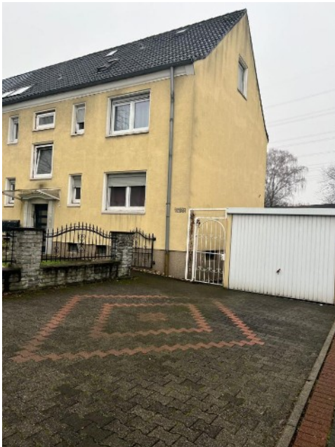
Durchgang Garten und Garage Außenbereich
