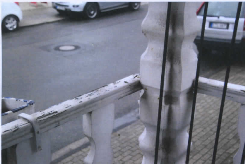
Bild 2 Holzbrüstung des Eingangspodestes
