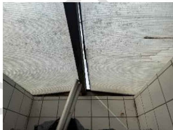
Verbindungselement der beiden Garagen
